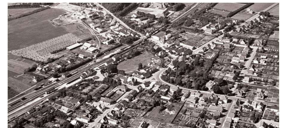
Luftfoto fra 1949. Byens gadestruktur, som vi kender den i dag aflæses tydeligt: Hærvejen nord-syd, Østergade og Vestergade. Byfælleden (i dag Rødekro Midt) og området ved den fremtidige Hærvejspark udgjorde på denne tid en meget grøn bymidte.
