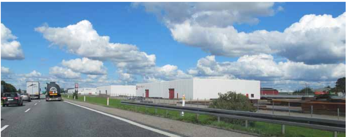
Lager og logistik ved Hedensted.
