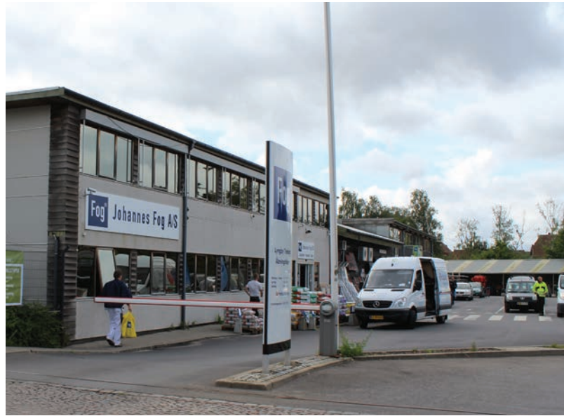
Firskovvejområdet i Kgs. Lyngby er et blandet erhvervsområde, som bl.a. rummer butikker med særligt pladskrævende varer, undervisning og kontorer. Det er vurderet via interviews i projektet, at området muligvis kan udnyttes til erhverv med større huslejevæne. Spørgsmålet er, om den nuværende anvendelse skal og kan fastholdes, eller om et muligt omdannelsespotentiale skal udnyttes.
