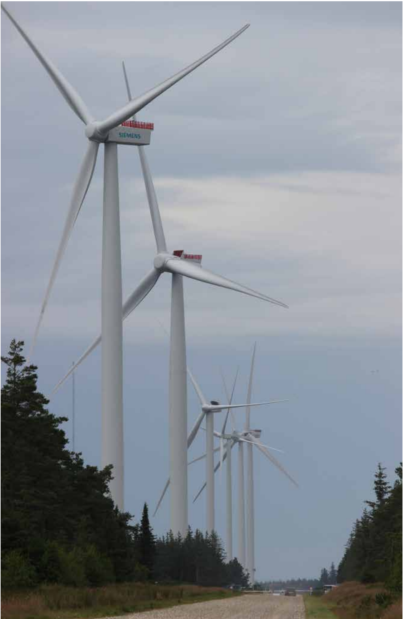
Østerild, foto: DTU Vindenergi
