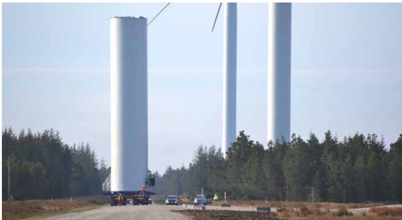
Østerild, foto: DTU Vindenergi
