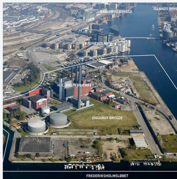
Luftfoto af Enghave Brygge set mod Nord. Havneholmen, Fisketorvet, Kalvebod Brygge, banearalerne samt Islands Brygge ses i baggrunden. JW Luftfoto 2011
